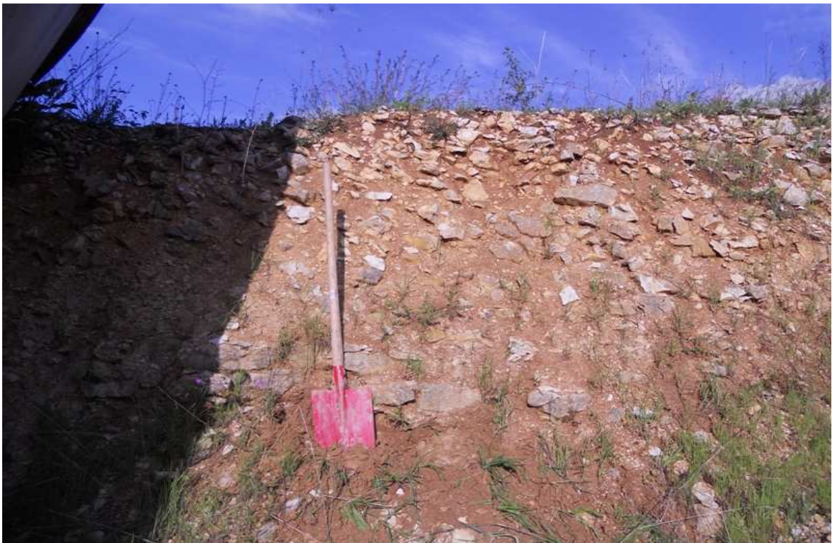
Figure 19. Profil du talus du versant en face du site pilote, avec des bancs de calcaire stratifiés en bas du talus à gauche et au milieu. La couleur de la matrice fine est différente.
