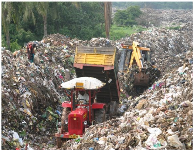
(d) Open dumping at Karuvadikuppam dump
